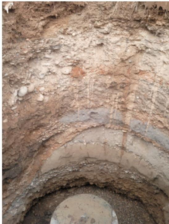
En 1979 le forage pour le puits de prélèvement de l'eau sur la nappe phréatique avait été analysé par un géologue. Il avait alors établi une description des couches de roches rencontrées (en géologie, on appelle cela un *log*) :
